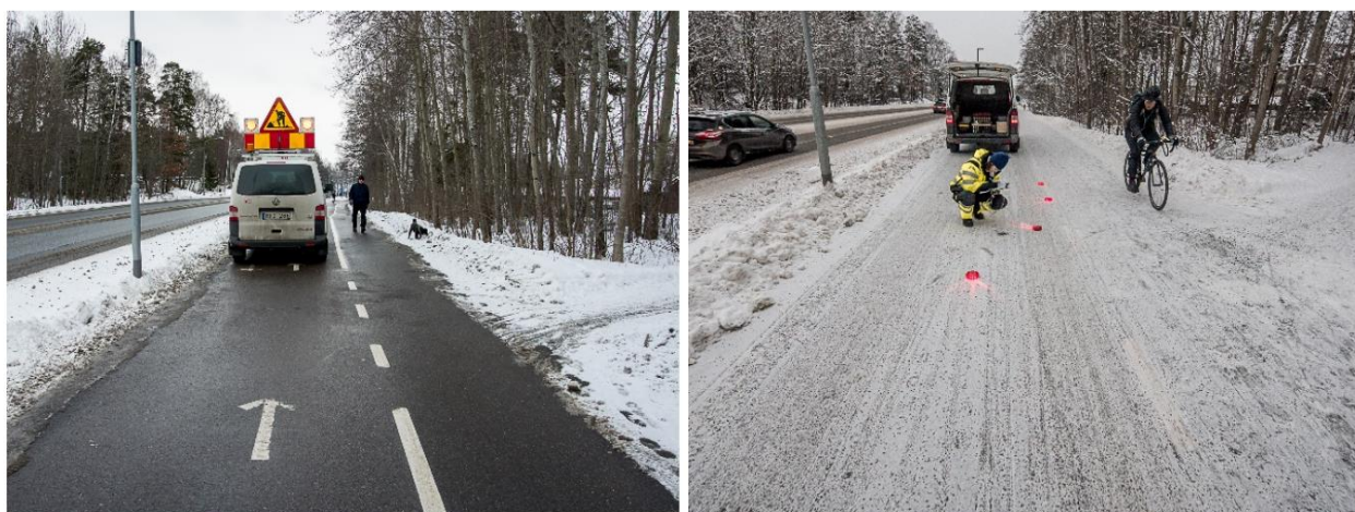
Figur 8. Forskjell mellom en gang- og sykkelvei som er sopsaltet (til venstre) og ploget og gruset (til høyre). Bilder fra det svenske forskningsinstituttet VTI (Niska & Blomqvist, 2019).
